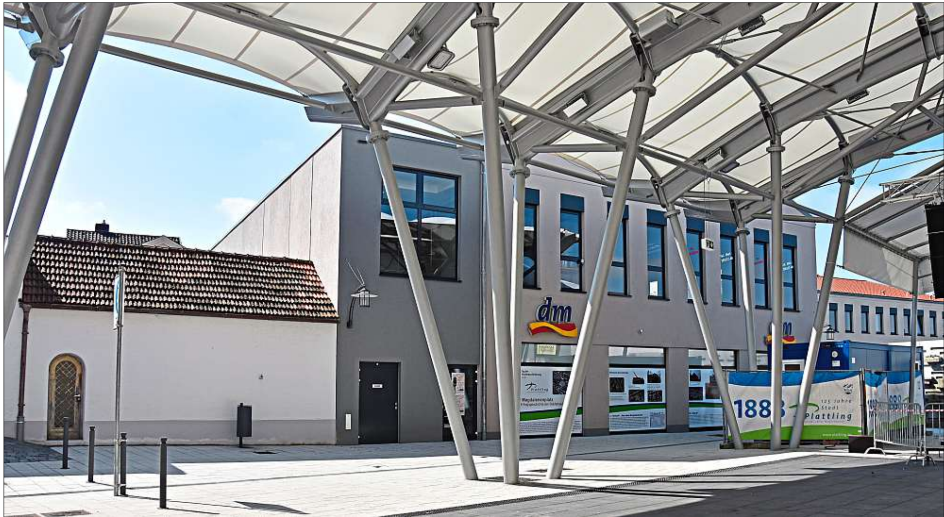
Blumenkühlung und Lager waren in der ehemaligen Kapelle untergebracht. Der kleine Anbau wird nun abgerissen, in die Lücke kommen die Toilettencontainer (rechts), die derzeit am Magdalenenplatz direkt neben der Bühne stehen müssen. – Foto: Hahne
